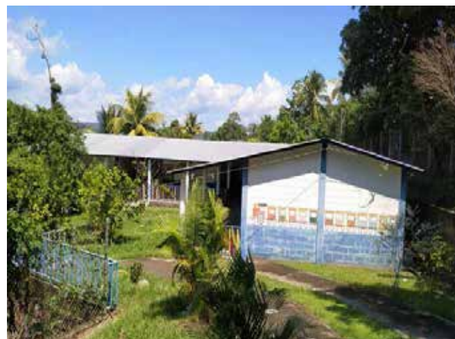
Escola d'educació especial Banyoles Solidària, construïda el 2013 amb l'ajut dels ajuntaments de Banyoles i Porqueres. © Banyoles Solidària
